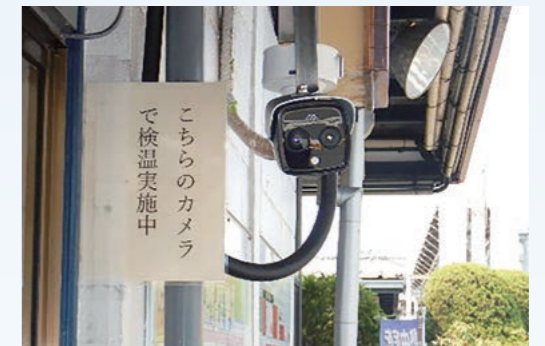
工場入口に設置されたサーモカメラ
