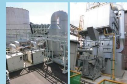
排ガス燃焼除害設備(写真左)とキャリアー燃焼除害設備(写真右)を擁し、生産工程から排出される環境負荷物質の削減に取り組んでいます。
