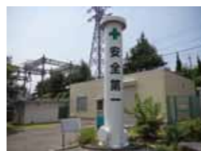
安全祈願の塔
