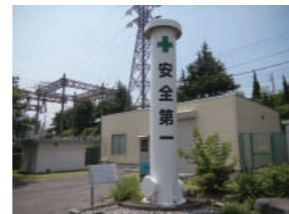
安全祈願の塔
