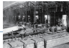
金属マグネシウム電解槽
