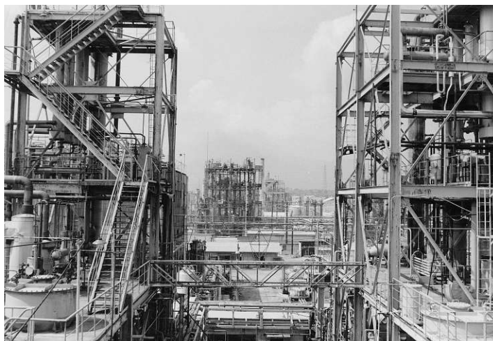
シクロヘキシルアミン 製造設備(中央に見えるのはパークロールエチレン製造設備)
