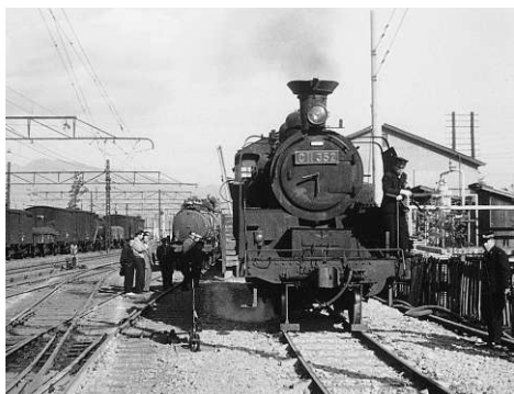
完工した専用側線延長工事
