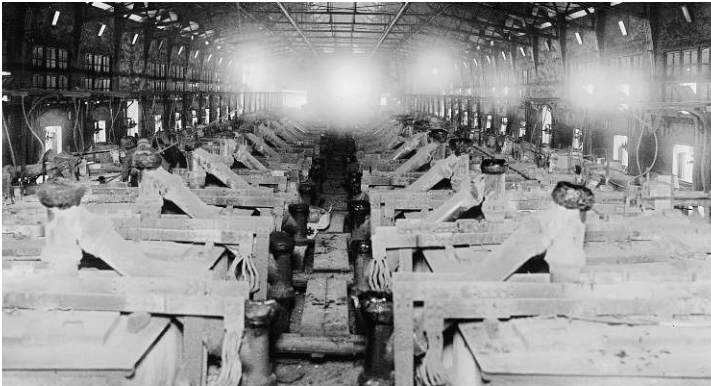
金属マグネシウム電解槽
