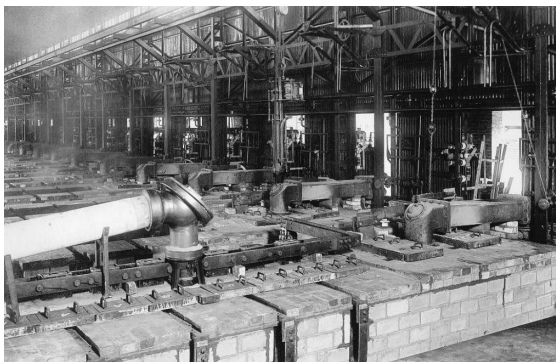
金属マグネシウム電解槽
