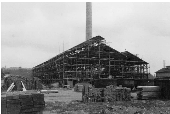
か性ソーダ煮詰工場の建設工事
