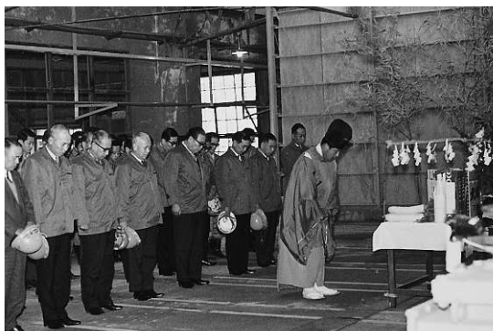
六フッ化硫黄製造設備の修祓式
