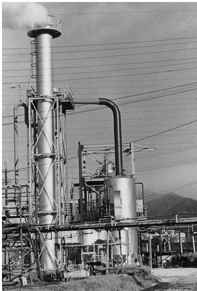
環境対策の一環として設置された炭化水素系廃液焼却処理設備(写真左)と塩素系廃液焼却処理設備
