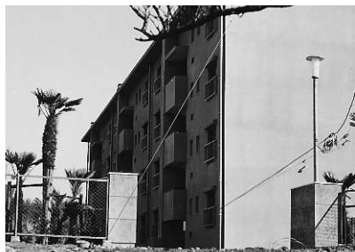
完成したK6アパート
